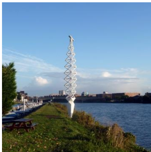
Neue Radarantenne am Ufer der Maas
