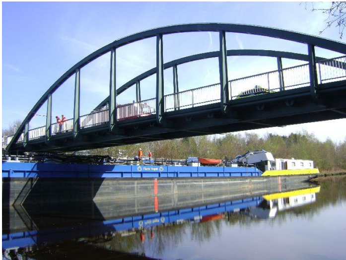
Gütermotorschiff nach Kollision mit einer Brücke
